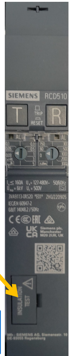
Wyzwalacz RCD510 wyłącznika CBR f-my SIEMENS wymaga wysunięcia ruchomego elementu w obudowie
